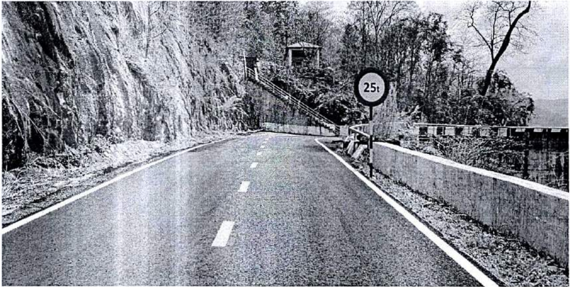
Hình 5c Biển báo hạn chế tải trọng trong khu vực đập
