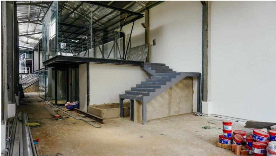
Hình 1.2 Hiện trạng xây dựng công trình
