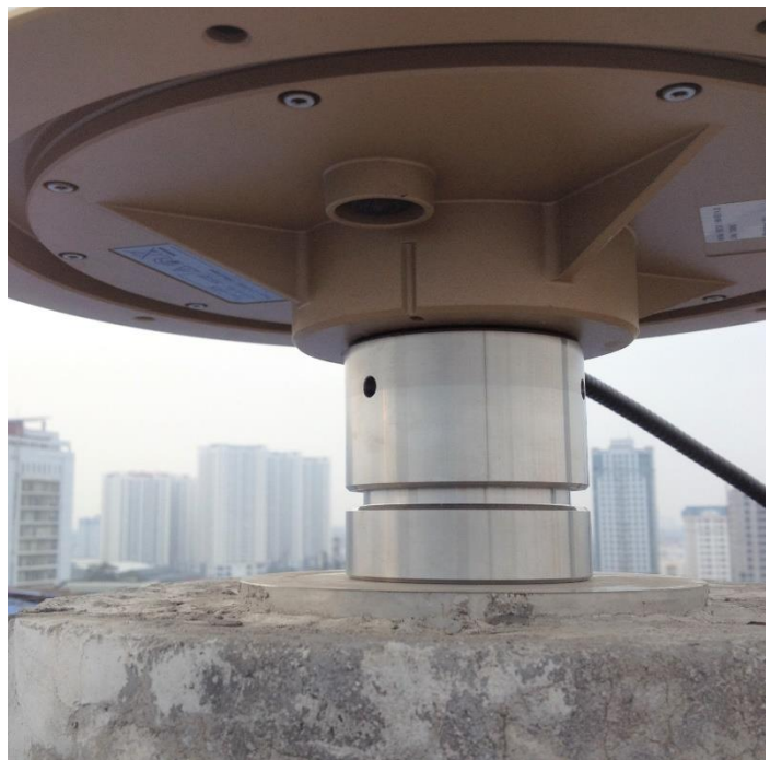
H4. Ăng-ten sau khi được lắp đặt
