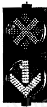
Hình 18. Đèn tín hiệu trước khu vực đo lường thứ cấp (ví dụ)
