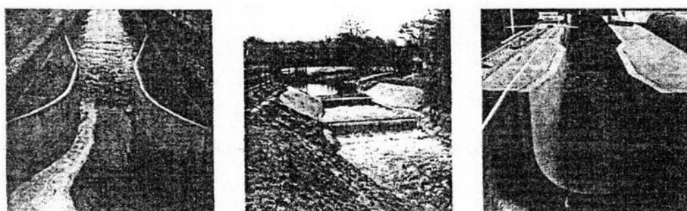
a) Máng có cổ hình chữ nhật b) Máng có cổ hình thang c) Máng có cổ hình chữ U
