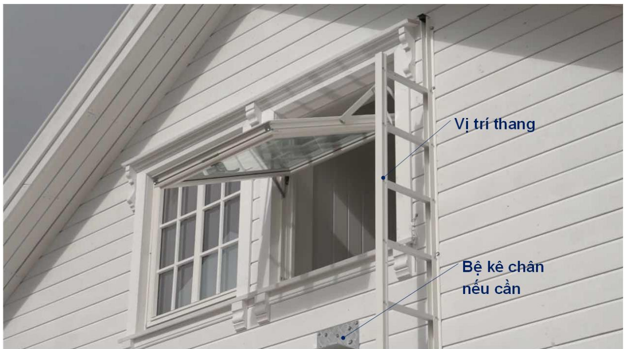
Thang ở trạng thái mở ra để sử dụng (vị trí lõi ra khỏi cấp trên cùng)
