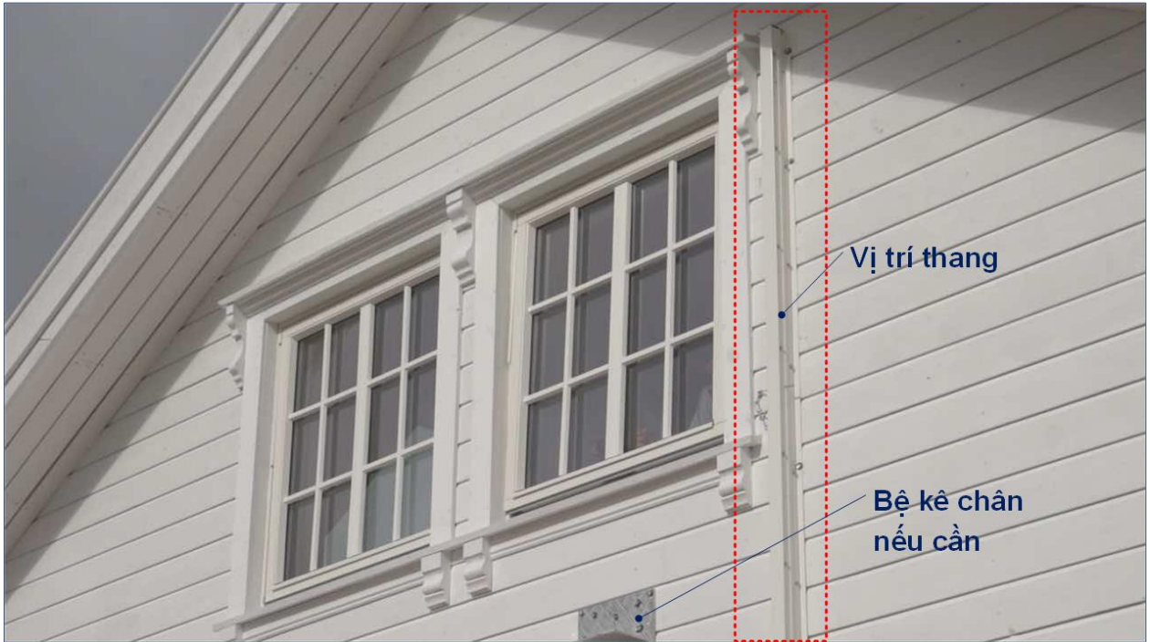
Thang ở trạng thái xếp dọc, ép sát bề mặt tường (vị trí lõi ra khỏi cấp trên cùng)
