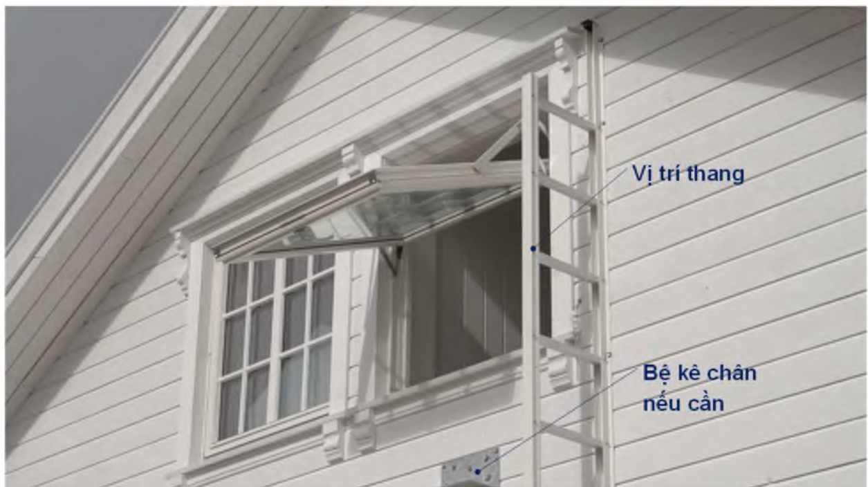
Thang ở trạng thái mở ra để sử dụng (vị trí lối ra khẩn cấp trên cùng)
