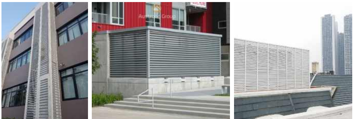
Ảnh tham khảo 14: Biện pháp che chắn đảm bảo mỹ quan thiết bị kỹ thuật công trình.
