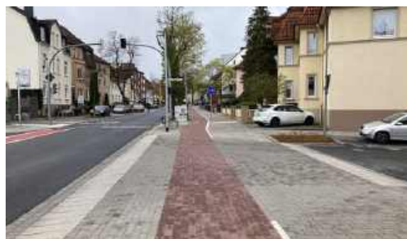
Ảnh tham khảo 25: Kết cấu vỉa hè kết hợp với bó vỉa dạng hạ thấp.
