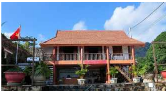
Công trình hiện có
