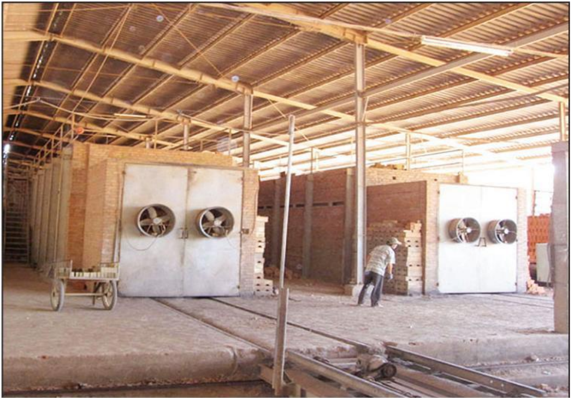
Hình 1: Công nghệ lò nung tuynel (lò hầm)
