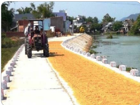
Hình 6.15. Đoạn đê ở huyện Tuy Phước được kiên cố chống xói lở năm 2019 (Nguồn: Báo nông nghiệp Việt Nam)
