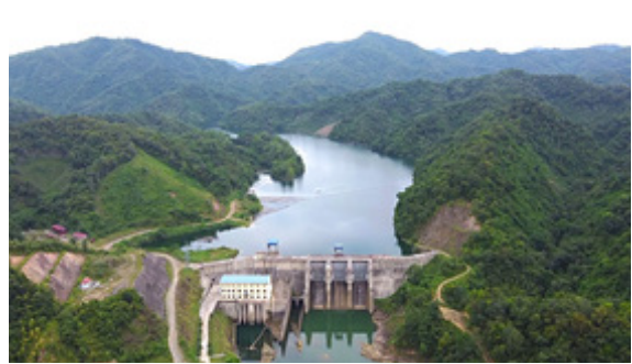
Hình 9. Nhà máy thủy điện Thác Xăng (huyện Tràng Định)
