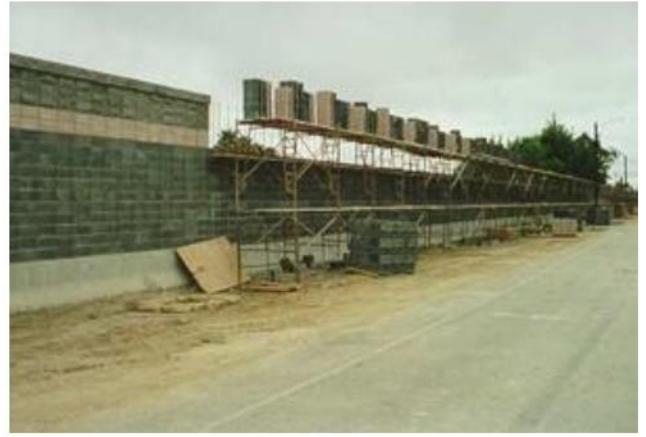
Hình 72 – Tường chống ồn bằng khối xây (minh họa)
