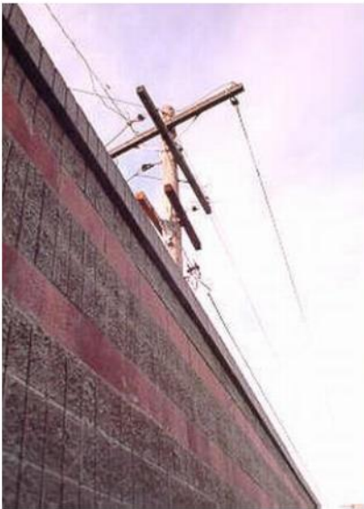
Hình 113 – Ảnh hưởng của các hạ tầng kỹ thuật trên cao đối với thiết kế tường chống ồn (minh họa)
