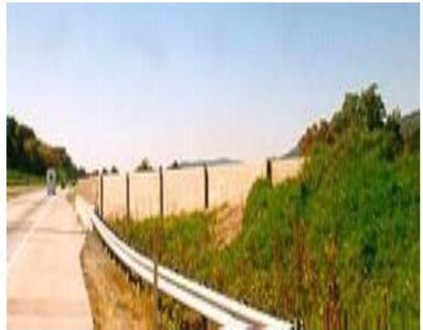
Hình 93 – Xử lý điểm kết thúc tường chắn ồn: Bờ đất (minh họa)
