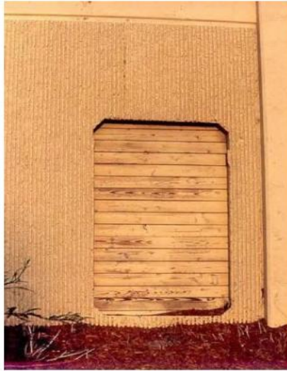
Hình 137 – Cửa đi qua tường chống ồn (minh họa)
