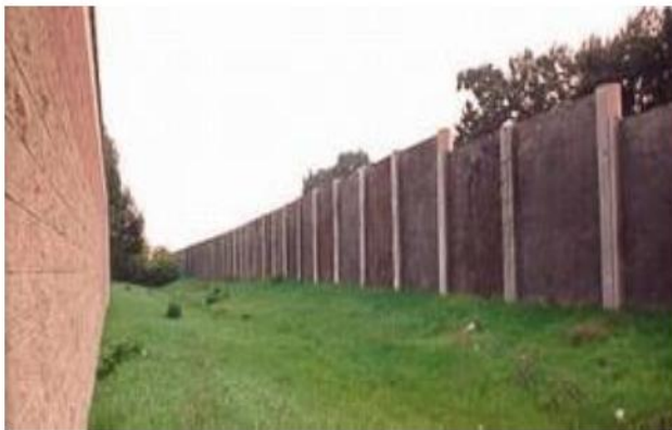
Hình 99 – Thoát nước: Sử dụng phần chồng lên nhau của tường chống ồn (minh họa)
