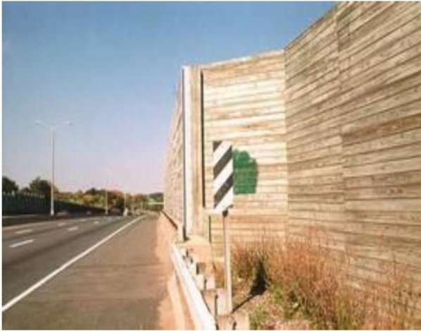
Hình 119 – Sự giãn nở và co ngót của vật liệu: Liên kết giữa các tường (minh họa)
