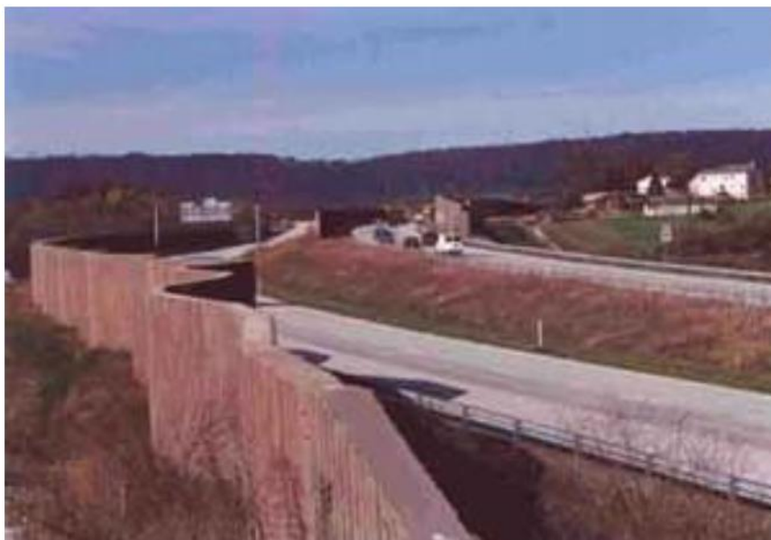
Hình 22 – Các tường chống ồn kiểu "zig-zag" (minh họa)
