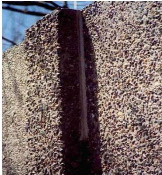
Hình 116 – Sự giãn nở và co ngót của vật liệu: liên kết cột với tấm panel (minh họa)
