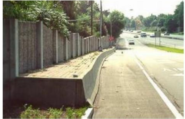
Hình 128 – Bảo vệ tường chống ồn khô và chạm với dòng xe (minh họa)
