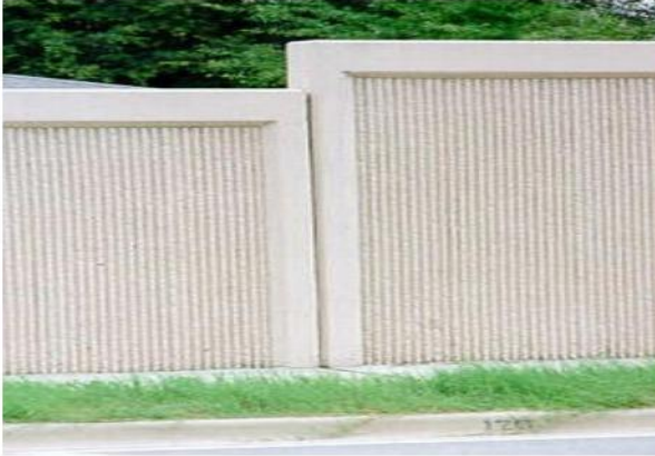
Hình 69 – Tường chống ồn bằng bê tông (minh họa)
