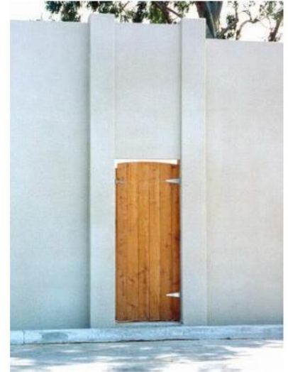
Hình 138 – Cửa đi qua tường chống ồn (minh họa)
