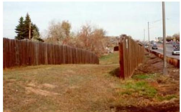
Hình 100 – Thoát nước: Sử dụng phần chồng lên nhau của tường chống ồn (minh họa)
