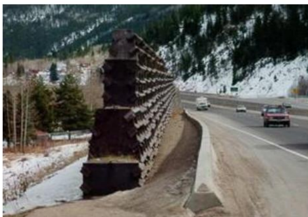
Hình 46 – Tường chống ồn dạng thùng: Thùng bằng nhựa (minh họa)
