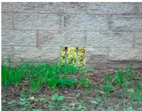
Hình 101 – Thoát nước: Bố trí khe thoát nước qua tường chống ồn (minh họa)
