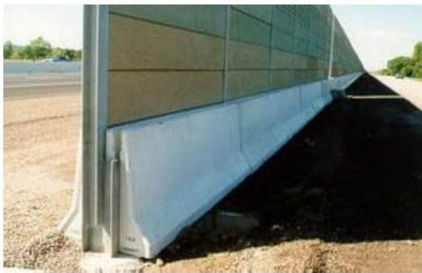
Hình 129 – Bảo vệ tường chống ồn khô và chạm với dòng xe (minh họa)
