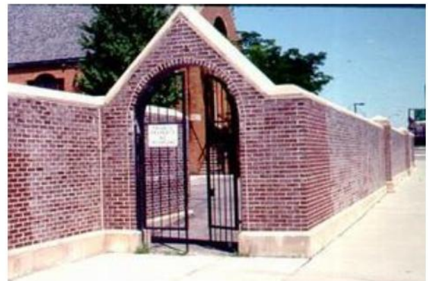
Hình 135 – Cửa đi qua tường chống ồn (minh họa)
