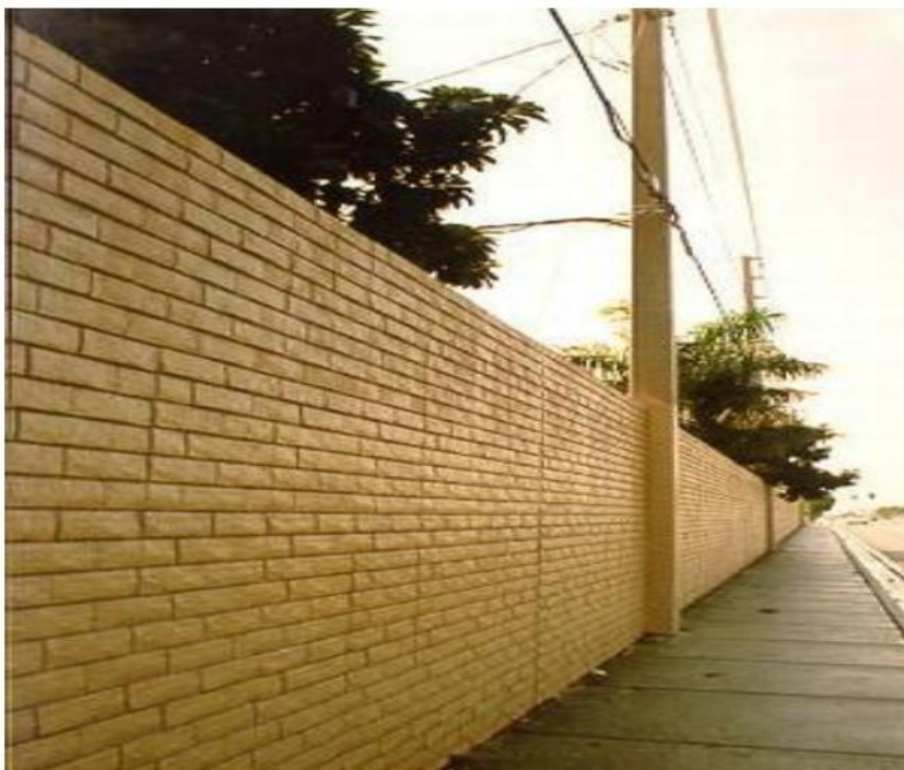
Hình 108 – Đèn chiếu sáng được kết hợp vào hệ thống tường chống ồn (minh họa)
