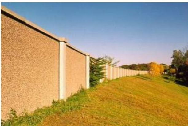
Hình 54 – Tổ hợp đê chống ồn và tường chống ồn (minh họa)
