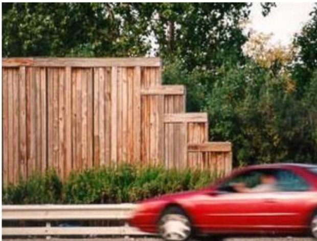
Hình 90 – Xử lý điểm kết thúc tường chống ồn: Tấm panel dạng bậc (minh họa)
