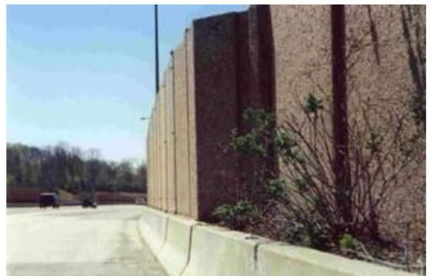
Hình 130 – Bảo vệ tường chống ồn khô và chạm với dòng xe (minh họa)
