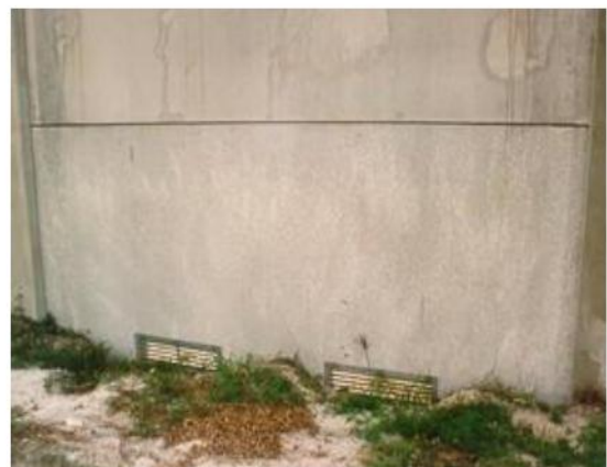
Hình 102 – Thoát nước: Bố trí khe thoát nước qua tường chống ồn (minh họa)
