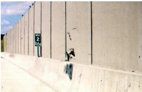
Hình 60 – Hư hại của tường chống ồn do va chạm của xe (minh họa)
