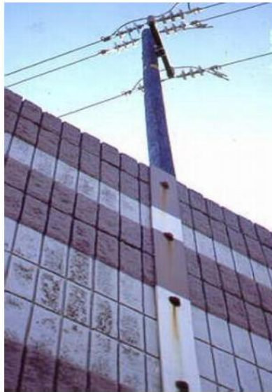
Hình 114 – Ảnh hưởng của các hạ tầng kỹ thuật trên cao đối với thiết kế tường chống ồn (minh họa)
