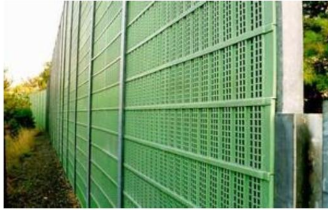
Hình 78 – Tường chống ồn bằng nhựa (minh họa)
