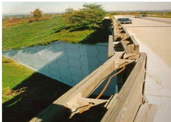
Hình 125 – Các chi tiết liên kết / gia cố tường chống ồn (minh họa)
