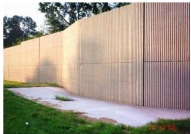
Hình 112 – Ảnh hưởng của công trình ngầm: Tường vòng tránh công trình ngầm (minh họa)
