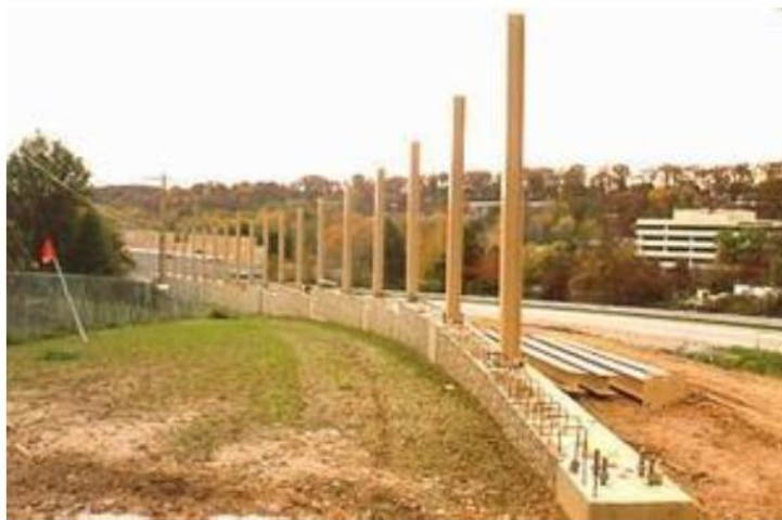
Hình 30 – Cột và tấm panel đi kèm: Móng băng (minh họa)
