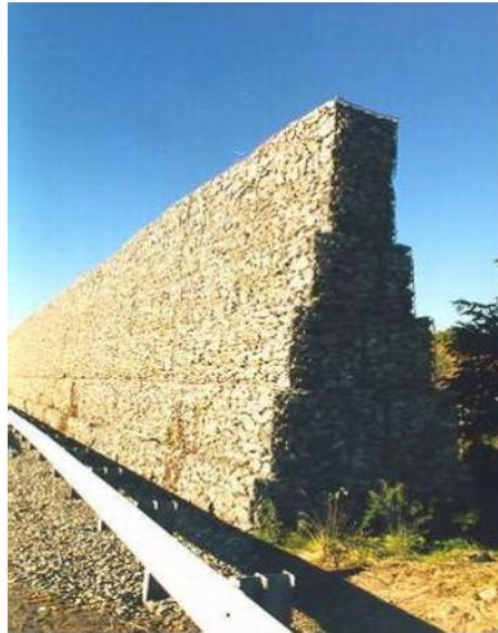
Hình 48 – Tường chống ồn bằng rọ đá (minh họa)
