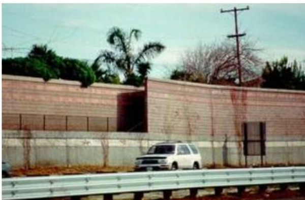
Hình 67 – Tường chống ồn phía sau tường chắn đất đúc tại chỗ (minh họa)
