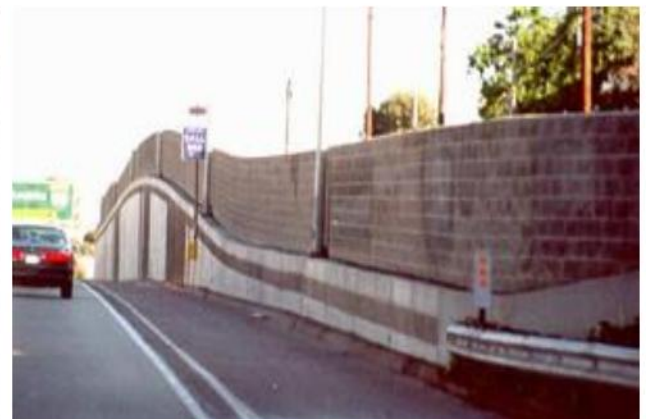
Hình 88 – Độ dốc dọc của tấm panel: Đều đặn, mềm mại (minh họa)
