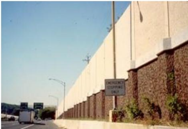
Hình 65 – Kết hợp tường chắn đất đúc tại chỗ và tường chống ồn (minh họa)
