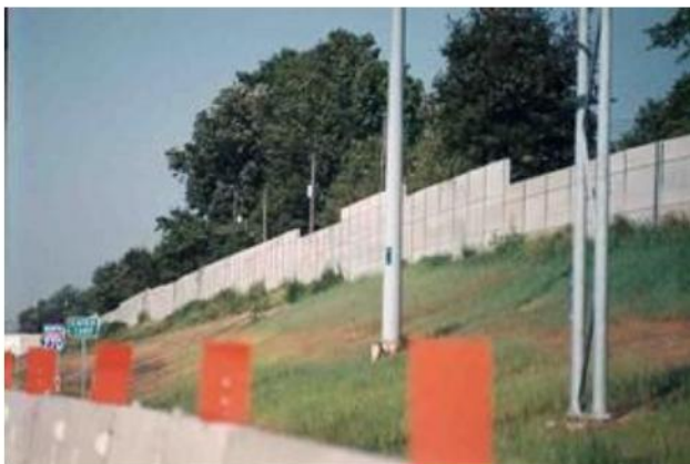
Hình 87 – Độ dốc dọc của tấm panel: Không đồng đều (minh họa)
