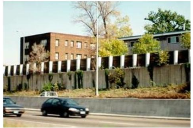
Hình 66 – Kết hợp tường chắn đất đúc tại chỗ và tường chống ồn (minh họa)
