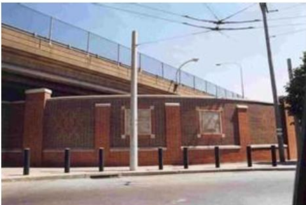
Hình 40 – Tường chống ồn xây bằng gạch (minh họa)
