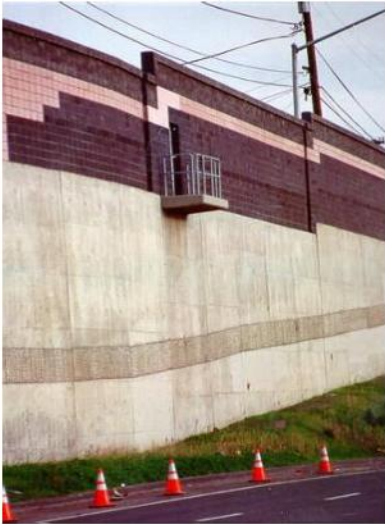
Hình 136 – Cửa đi qua tường chống ồn (minh họa)
