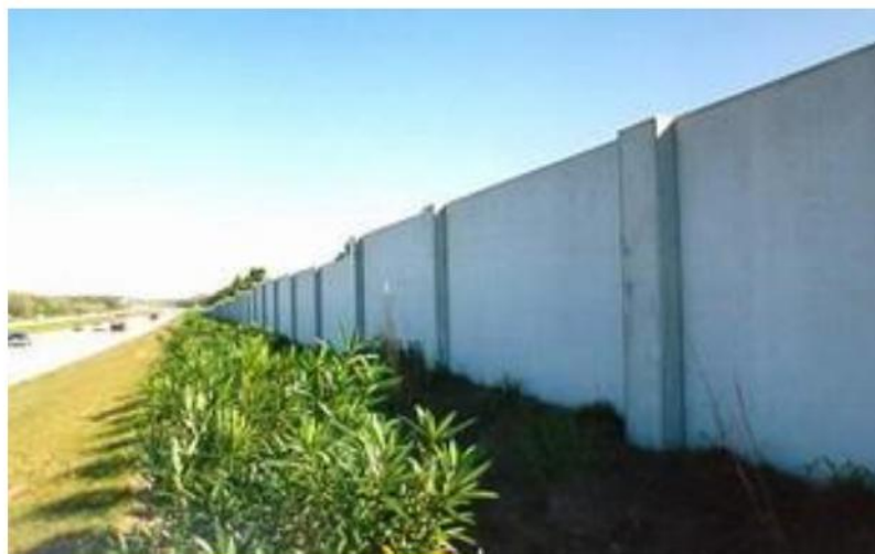
Hình 32 – Tấm panel toàn chiều cao (minh họa)
