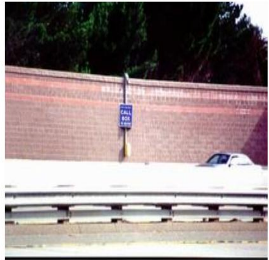
Hình 110 – Gắn hộp điện thoại khẩn cấp trên tường chống ồn (minh họa)
