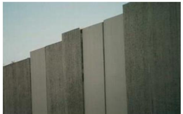
Hình 50 – Các tấm panel chôn trực tiếp (minh họa)
