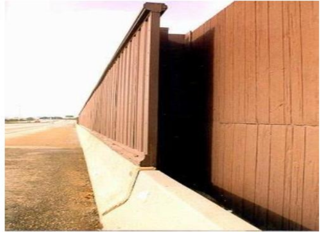
Hình 120 – Sự giãn nở và co ngót của vật liệu: Liên kết giữa các tường (minh họa)
