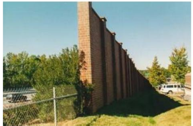
Hình 41 – Tường chống ồn xây bằng gạch (minh họa)
