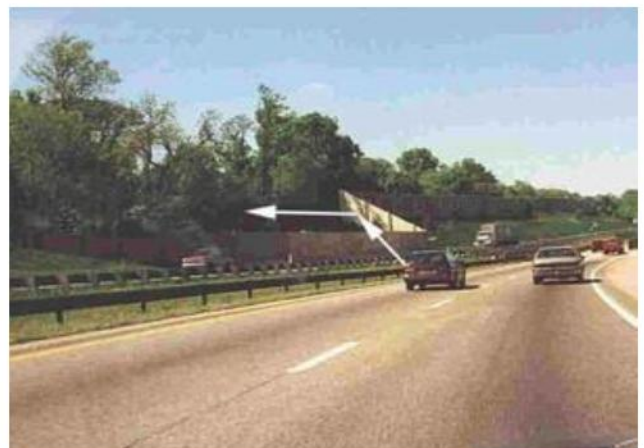
Hình 84 – Thay đổi hướng tường chắn ồn: có thể có phản xạ tiếng ồn bên sườn (minh họa)
