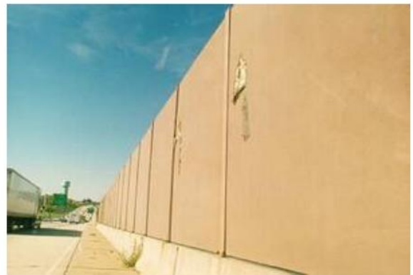
Hình 61 – Hư hại của tường chống ồn do các mảnh vỡ từ trên không (minh họa)
