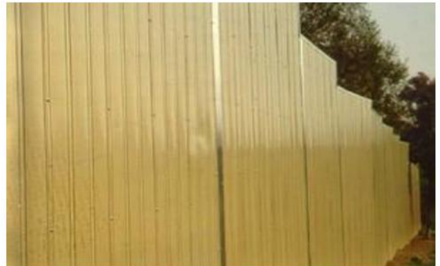
Hình 74 – Tường chống ồn bằng nhôm (minh họa)
