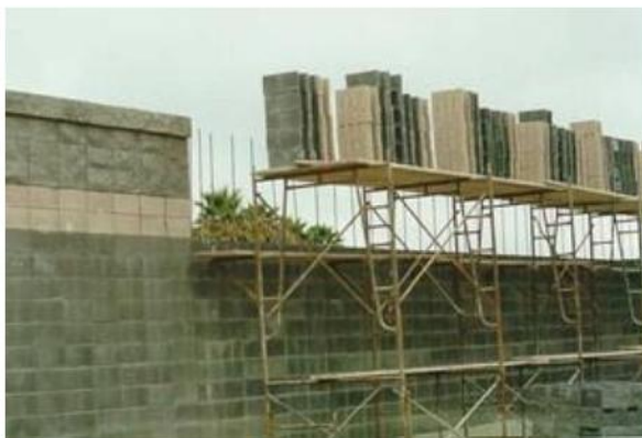
Hình 42 – Tường chống ồn bằng khối xây (minh họa)
