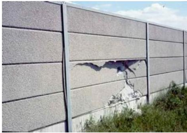
Hình 37 – Cột và tấm panel: Xem xét đến việc bảo trì (minh họa)
