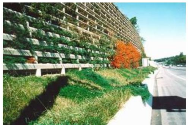
Hình 47 – Tường chống ồn "trồng cây": Khung bê tông (minh họa)
