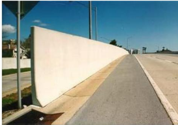
Hình 53 – Tường chống ồn bằng bê tông đúc tại chỗ (minh họa)
