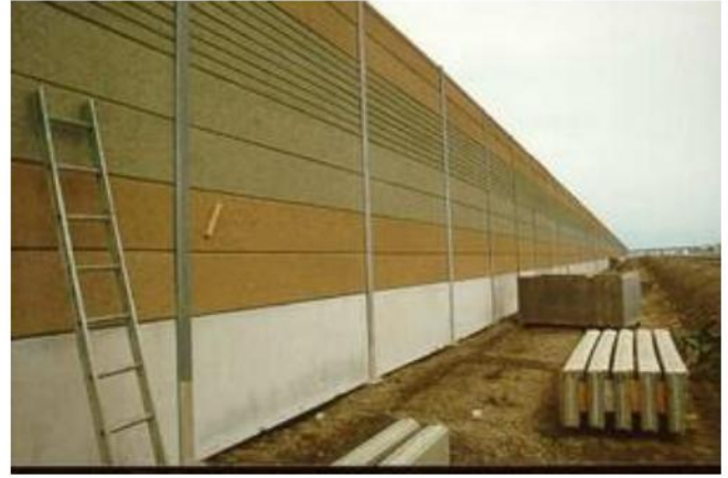
Hình 81 – Tường chống ồn bằng vật liệu tổng hợp (minh họa)
