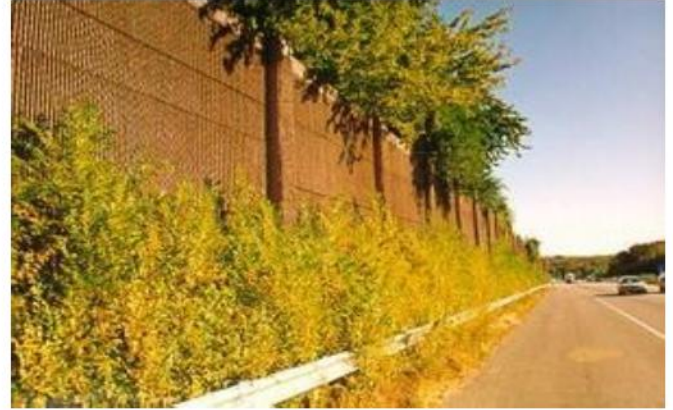
Hình 70 – Tường chống ồn bằng bê tông (minh họa)
