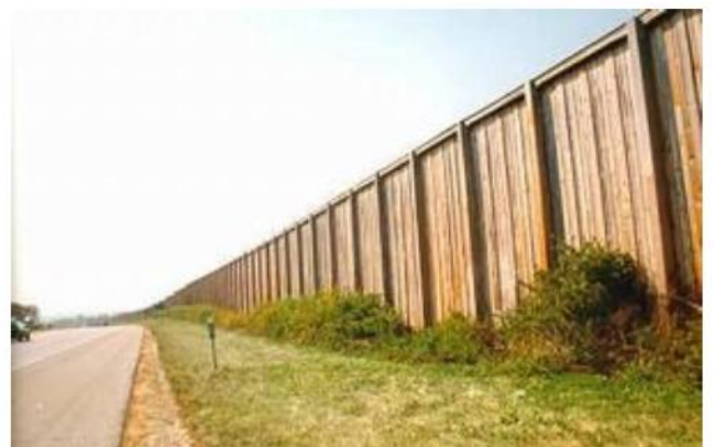
Hình 76 – Cột gỗ dán và ván gỗ của tường chống ồn (minh họa)
