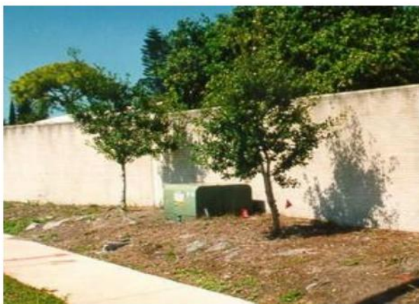
Hình 111 – Ảnh hưởng của công trình ngầm: Tường dùng móng nông có chân mở rộng hoặc không cần móng (minh họa)
