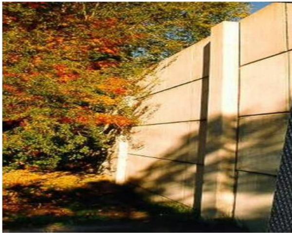
Hình 92 – Xử lý điểm kết thúc tường chắn ồn: Thảm thực vật (minh họa)
