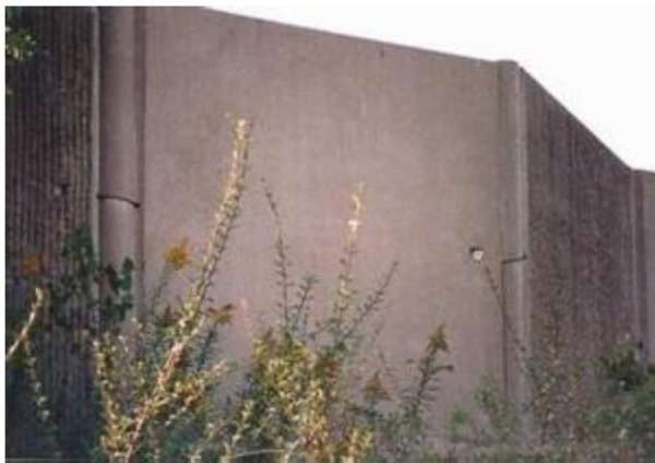
Hình 117 – Sự giãn nở và co ngót của vật liệu: liên kết cột với tấm panel (minh họa)
