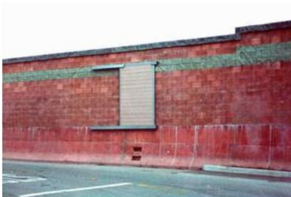
Hình 134 – Cửa đi qua tường chống ồn (minh họa)
