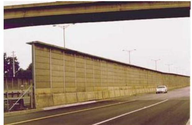
Hình 25 – Đỉnh dạng chữ T của tường chống ồn (minh họa)
