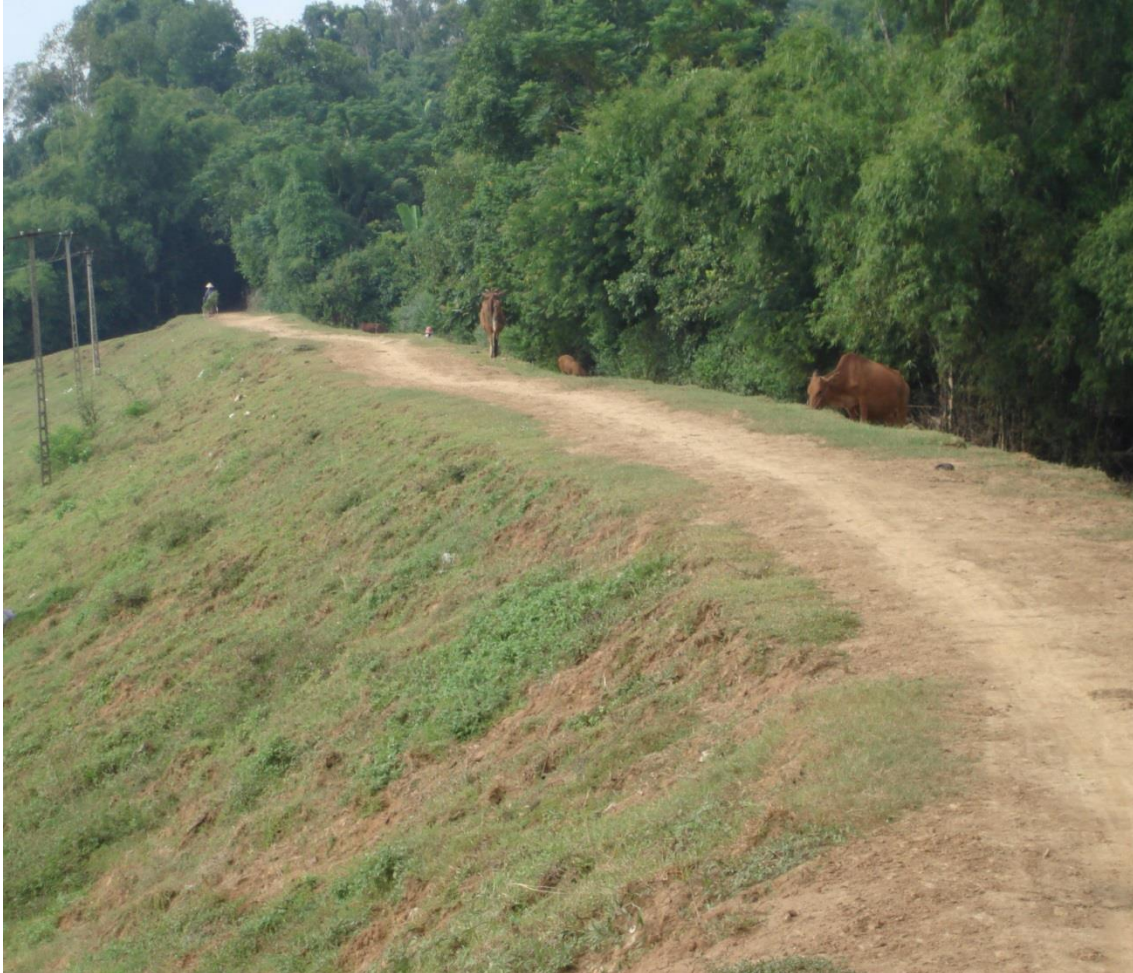
Một đoạn La thành
