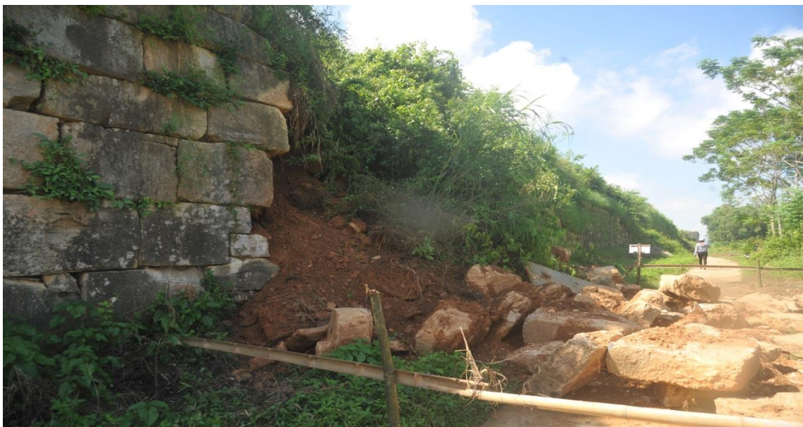
Một đoạn tường thành phía bắc bị sạt lở do bão năm 2017
