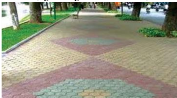
Mẫu 3: Gạch bê tông tự chèn, màu gạch toàn khối. Ưu tiên sử dụng, cần chú trọng khâu phối màu gạch nhằm tăng vẻ mỹ quan đô thị
